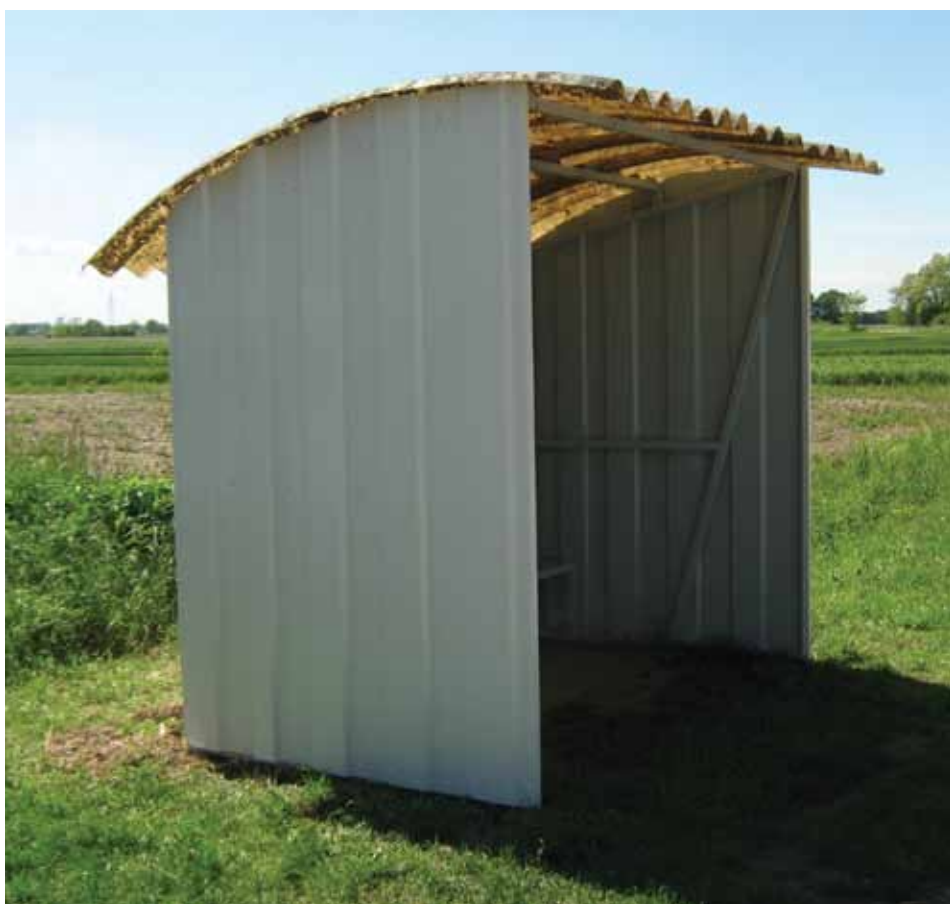
Obnovljena nadstrešnica u Podbrestu
