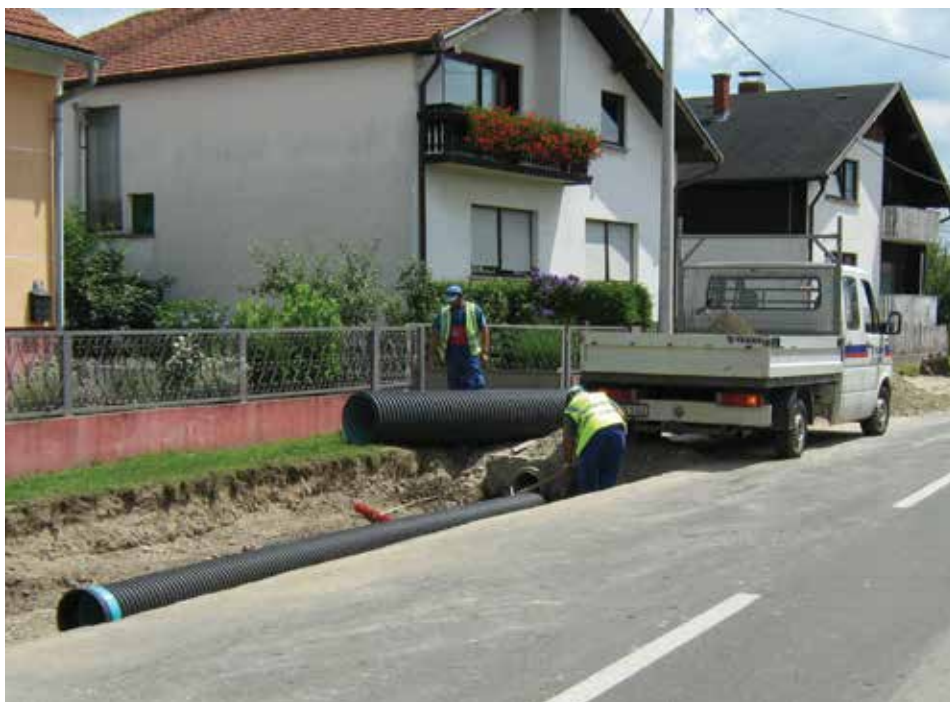
Izgradnja pješačko-biciklističke staze u ulici Zrinskih u Orehovici
