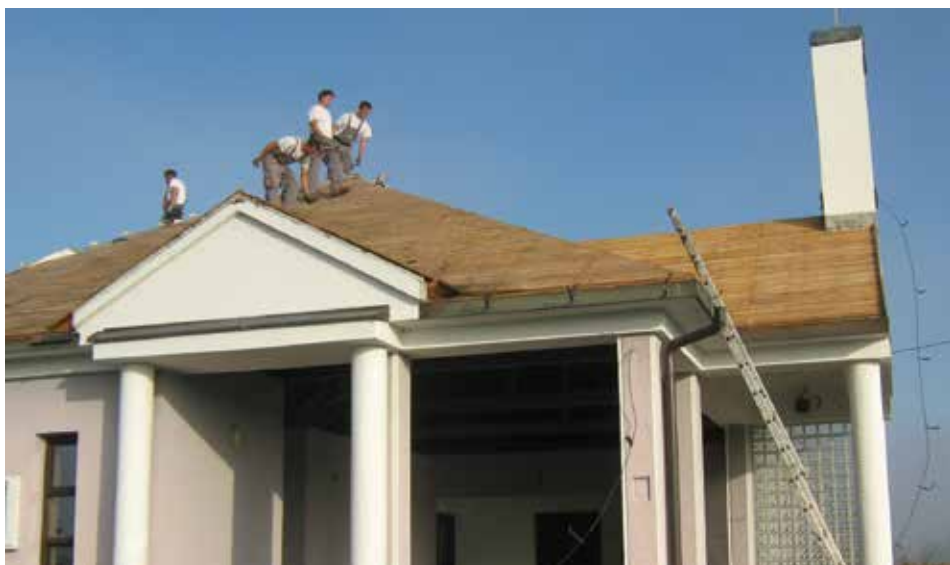
Sanacija krovišta grobne kuće u Orehovici
