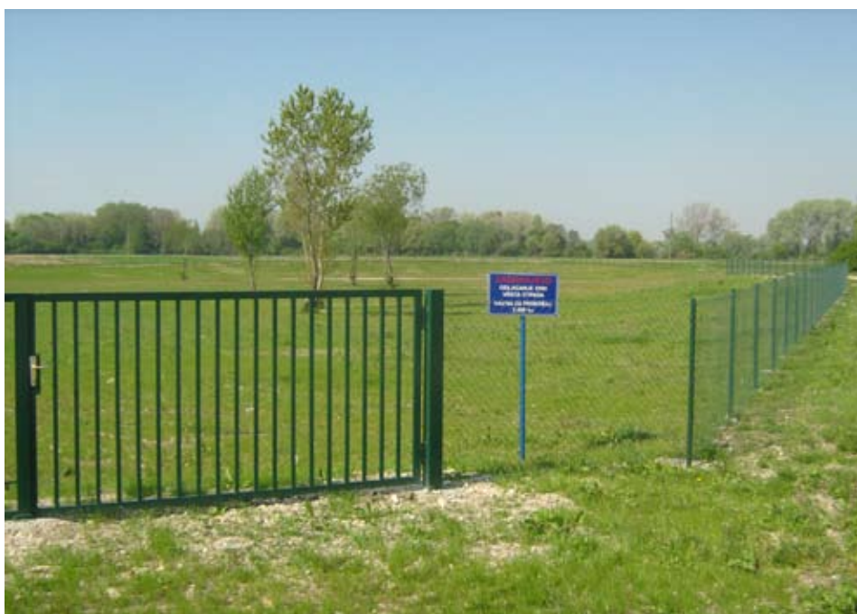
Deponija „Prosišće“ nakon sanacije
