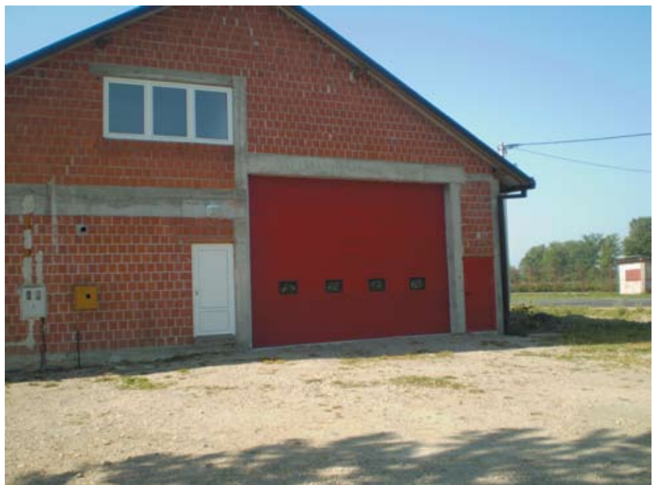
Ulaz u vatrogasno spremište objekta
