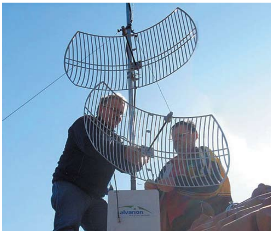
Postavljanje bežične opreme od strane članova udruge OrehovicaWireless na krovu zgrade OŠ Orehovica
