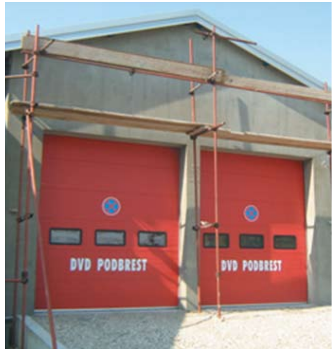
Izrada toplinske fasade na vatrogasnom spremištu DVD-a Podbrest
