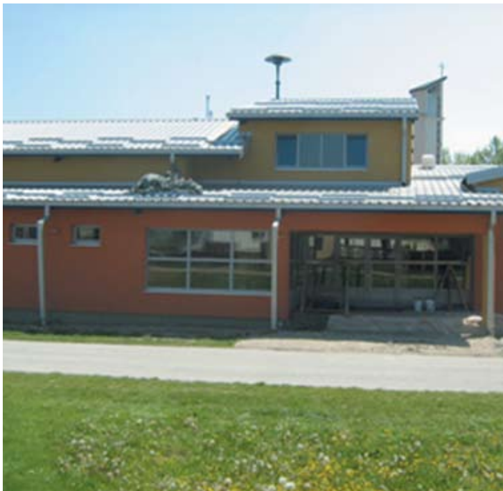
Izrada toplinske fasade na Domu kulture u Podbrestu
